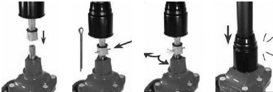
Рис. 4 Порядок установки телескопического штока на задвижку.
